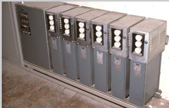
Gruppo di condensatori con fusibili separati
