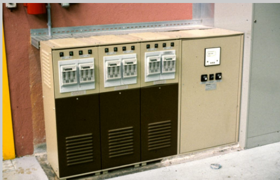
Impianto di compensazione autonomo
