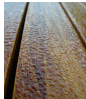
Legno trattato con prodotto di protezione
